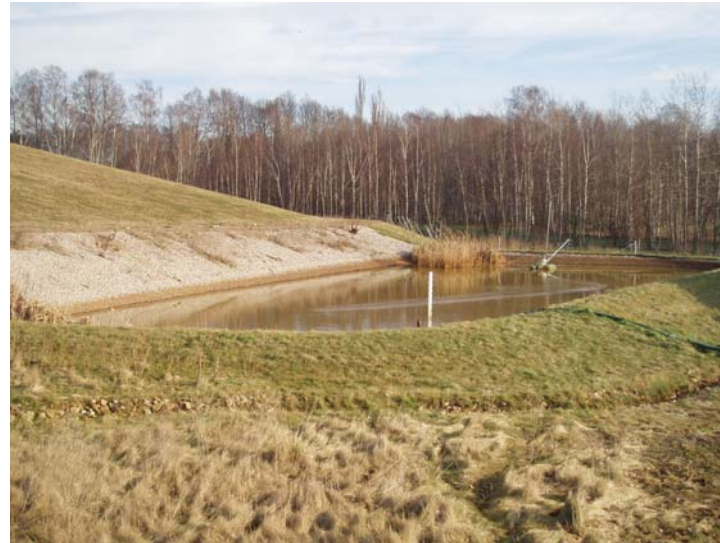
Deponiefuß Süd mit Wasservorlage
